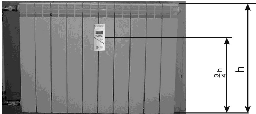
Рис. 1.1. Установка измерителя ИНДИВИД.
